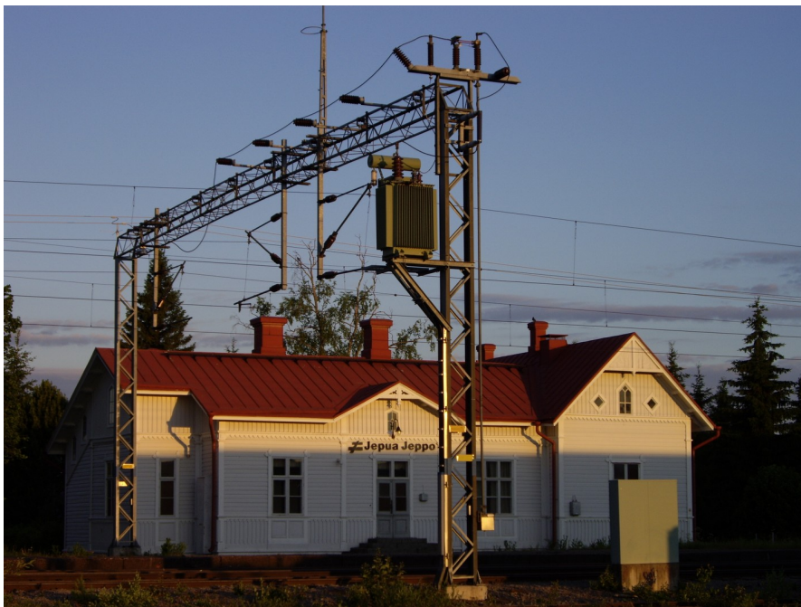
Jeppo station, byggd 1885, på Orrholmen
